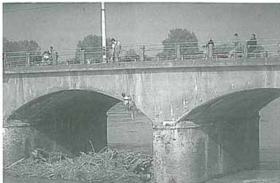
1996 - Disostruzione arcate ponte ferroviario sul fiume Tanaro
